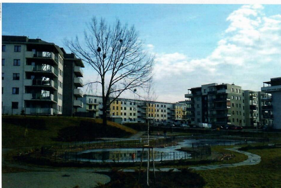
Potrzebne są rozwiązania umożliwiające racjonalne wykorzystanie wody na terenach miejskich (osiedle Kajki w Elku)
